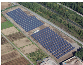
松本太陽光発電所
