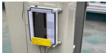
▲ 空調室外機に設置されているものが出力制御装置
