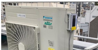
▲ 空調室外機に設置されているものが出力制御装置
