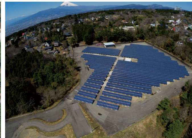
葦山太陽光発電所
