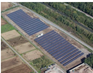
松本太陽光発電所
