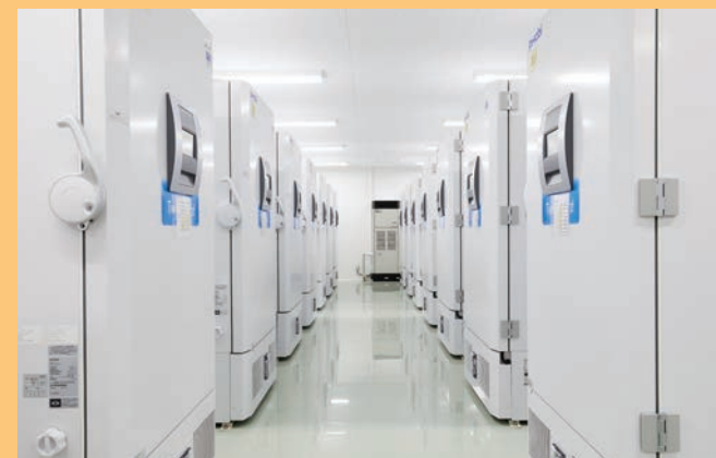
関東地区保管センター 保管区画
