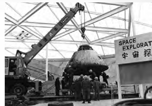
アポロ宇宙船の据付作業
