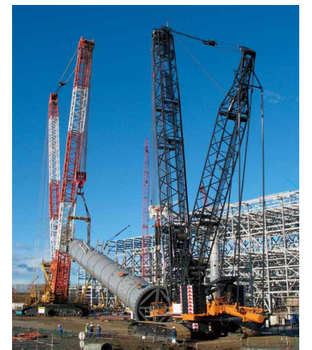
サハリンでのタワー据付作業
