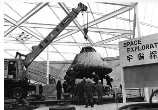
アポロ宇宙船の据付作業
