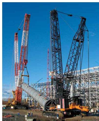
サハリンでのタワー据付作業
