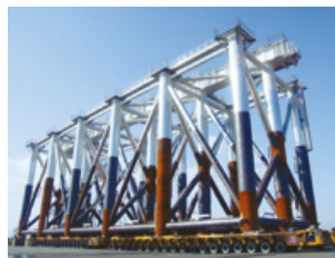
東京国際空港の橋脚運搬
