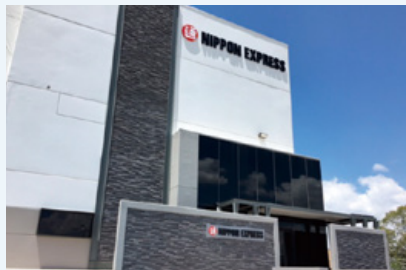
メキシコ日本通運株式会社 アグアスカリエンテス・ロジスティクスセンター
