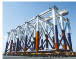
東京国際空港の橋脚運搬
