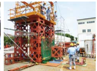
高所作業の実習
