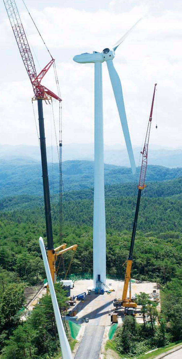
風力発電設備据付工事の様子
