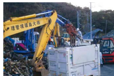
大島町内における積込作業
