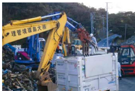
大島町内における積込作業
