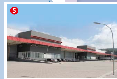
ブラジル日通 カジャマール・ロジスティクス・センター
