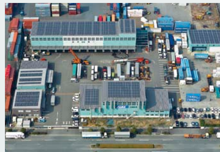
福岡整備工場上空から見た太陽光発電パネル
