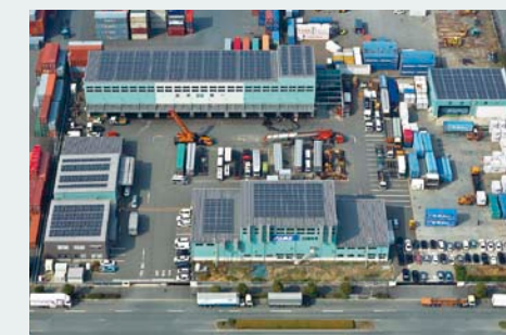
福岡整備工場上空から見た太陽光発電パネル
