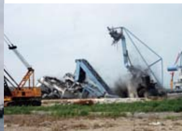
アンローダー撤去作業
