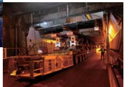
天井板の搬出作業
