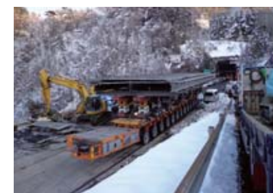
天井板の搬出作業
