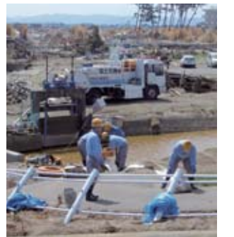
水門が壊れた沿岸部での排水作業
