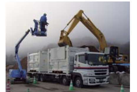
がれきをコンテナに積み込む作業
