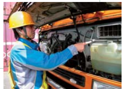
サイトグラスによるエアコンガスの状態チェック
