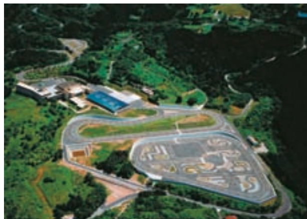
安全に関する教育が実施されている伊豆研修センター
