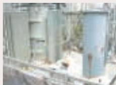
今回の運搬対象物は重さ約20トンの変圧器です（写真左）。中にはPCBを含有する絶縁油が入っています。その大きさから、運搬に際して放熱機を取り外す必要があるのですが、そのために中の絶縁油を抜油するという大作業を行います。
