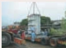
変圧器本体部分のトレーラへの積載の様子です。ここでも漏れ防止型金属トレイを使用します（左）。
