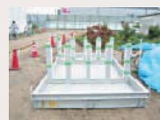
抜油後、運搬できるサイズまで解体します（左）。写真（右）のような漏れ防止型金属トレイに載せての運搬となります。今回のトレイは運搬物に合わせて特別に作製したものです。
