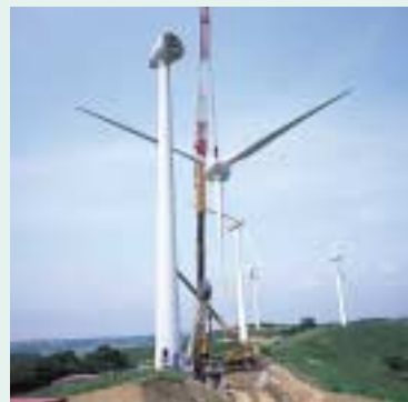
風力発電設備の建設
