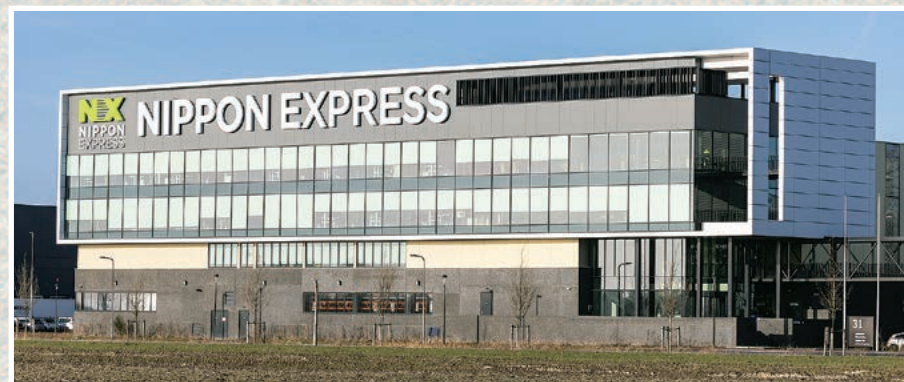
スキポール・エアポート・ロジスティクスセンター
