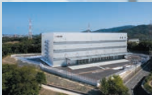
九州医薬品センター
