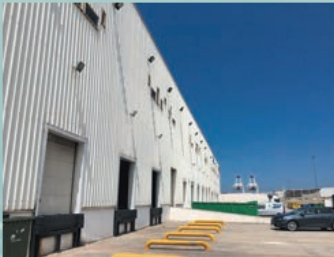
タンジェMed・ロジスティクスセンター
