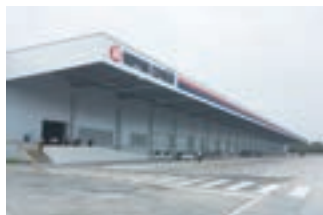
アマタシティチョンブリ ロジスティクスセンター外観
